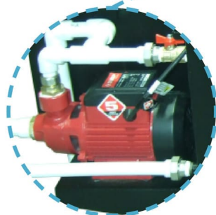
Электродвигатель 0.4 кВт
